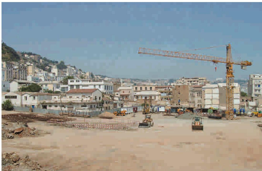
Foto 2: Baugrube für eine Haltestelle der U-Bahn-Linie 1
